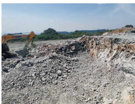
รูปที่ 2-23: การทำความสะอาดหน้างาน ก่อนการระเบิด
